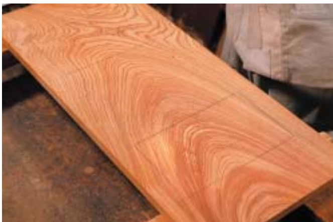
사진 57. 천판에 문구멍과 장부구멍 표시
