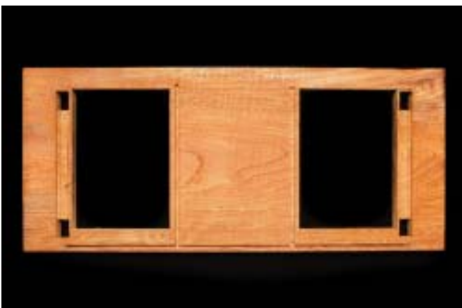
사진 59. 문구멍과 장부구멍을 낸 모습
