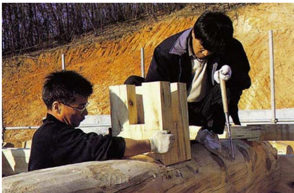
사진134. 동자주 설치
