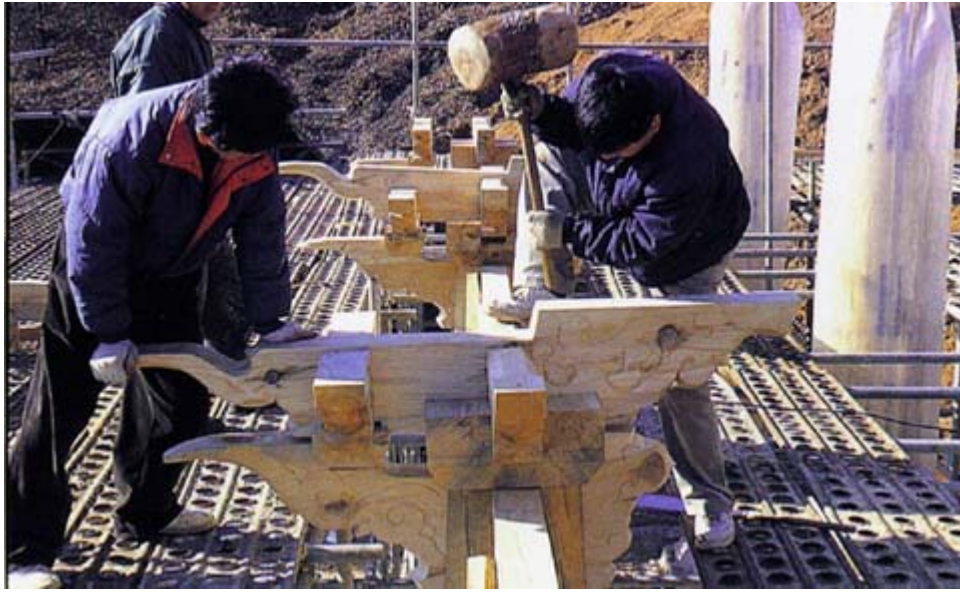
사진122. 주두 설치후 주심첨차 출목첨차 이익공 설치
