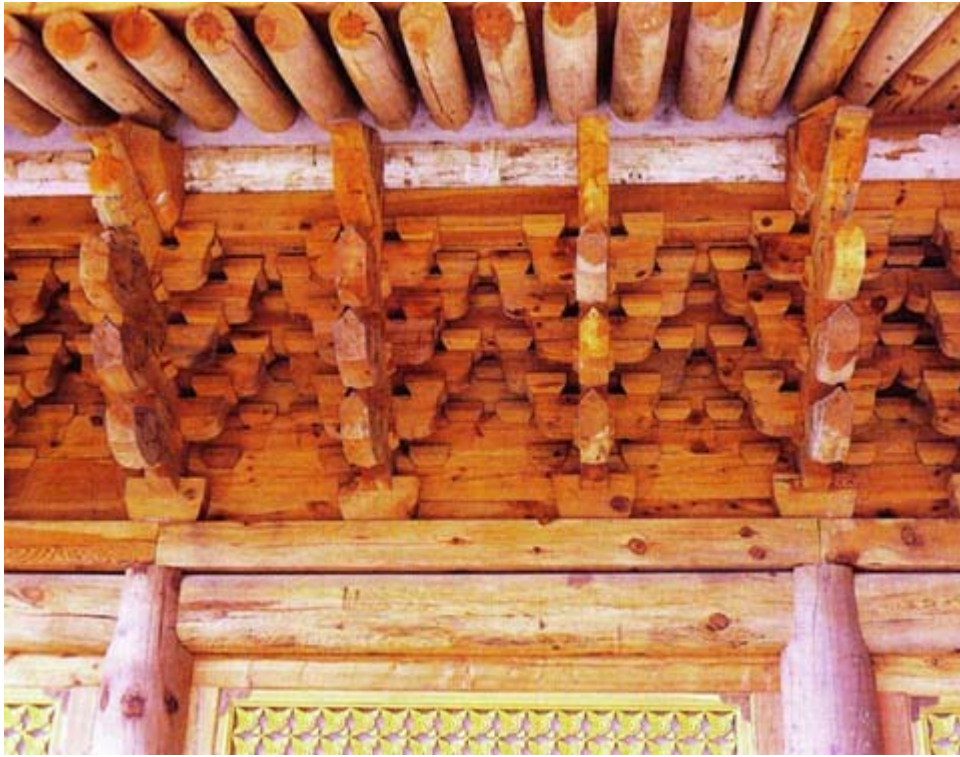
사진190. 단청하기 전 구인사 조사전 다포 모습
