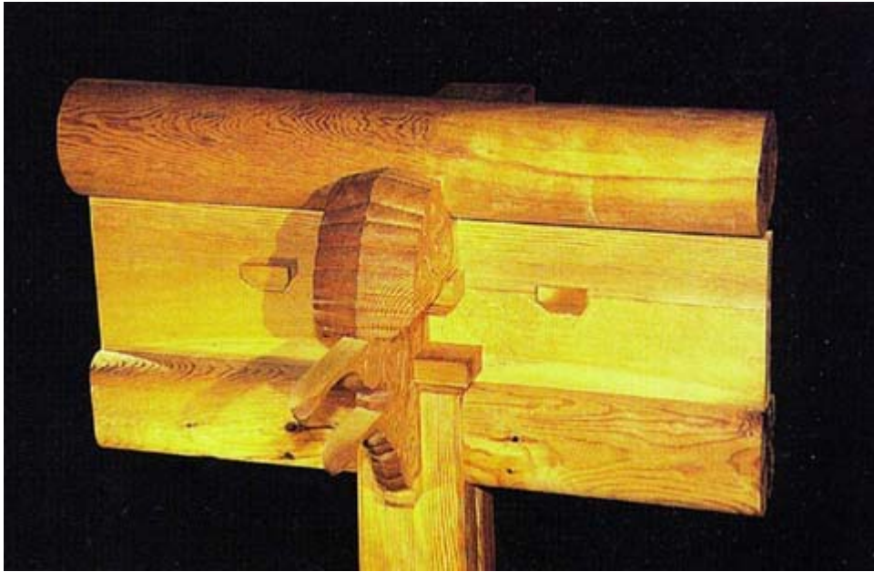
사진59. 굴도리 설치
