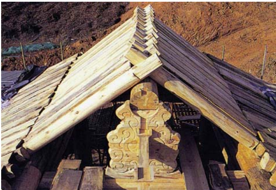
사진151. 단연 설치
