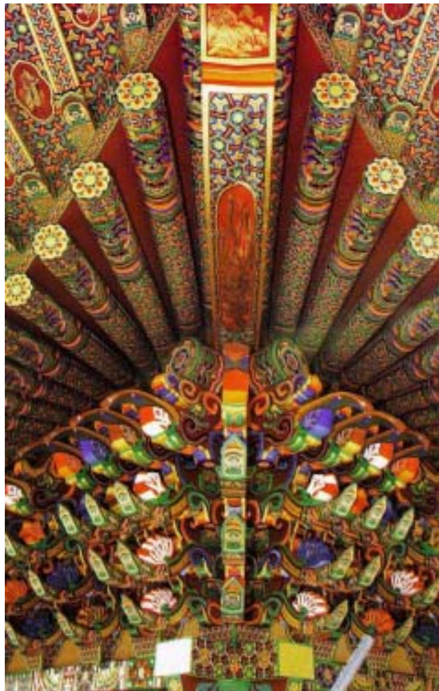
사진184. 구인사 추녀와 서까래, 귀포의 모습
