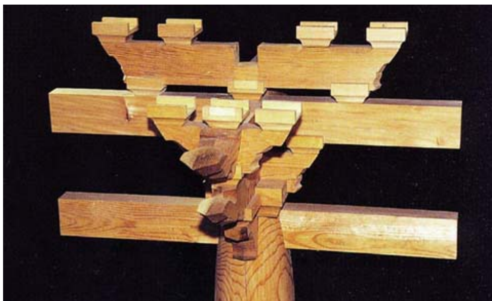
사진84. 대량위 주심첨차 설치
