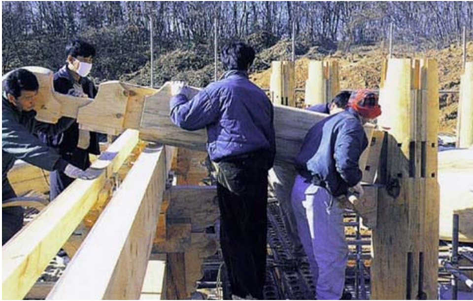
사진126. 주심장혀 출목장혀 설치 후 퇴량 설치 과정
