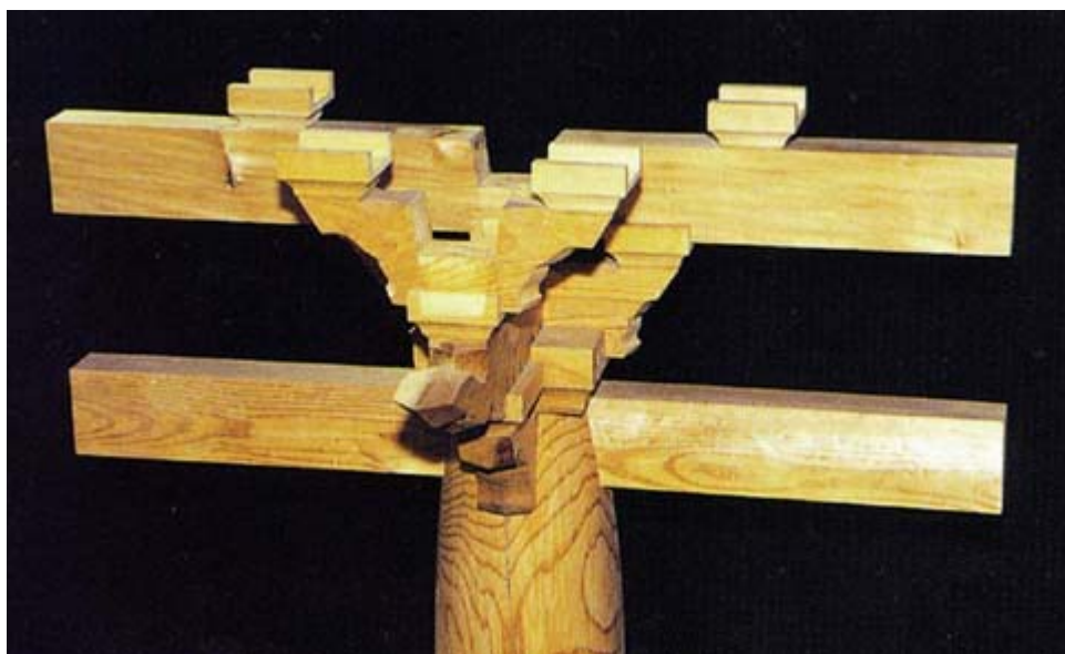
사진82. 주심장혀와 출목참차 설치
