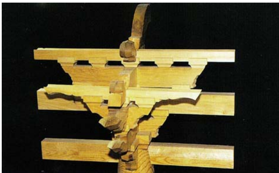
사진86. 주심장혀 출목 단장혀 우미랑 설치
