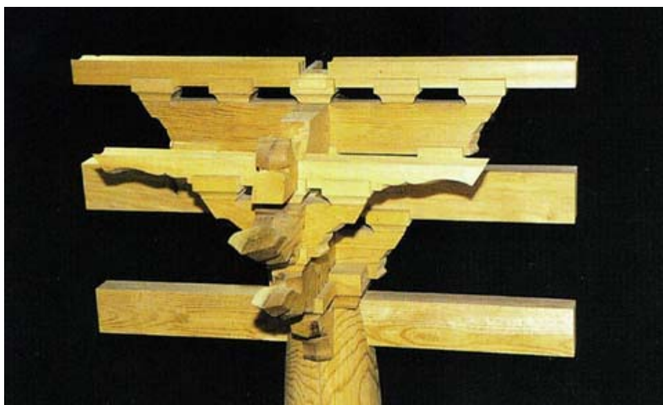
사진85. 주심장혀와 출목첨차 설치
