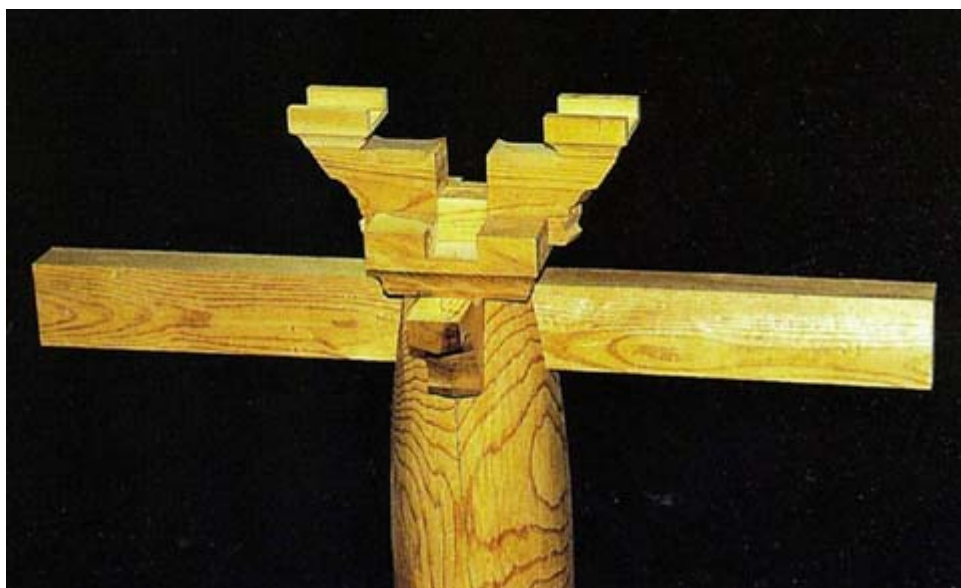
사진80. 주두위 주심첨차 설치
