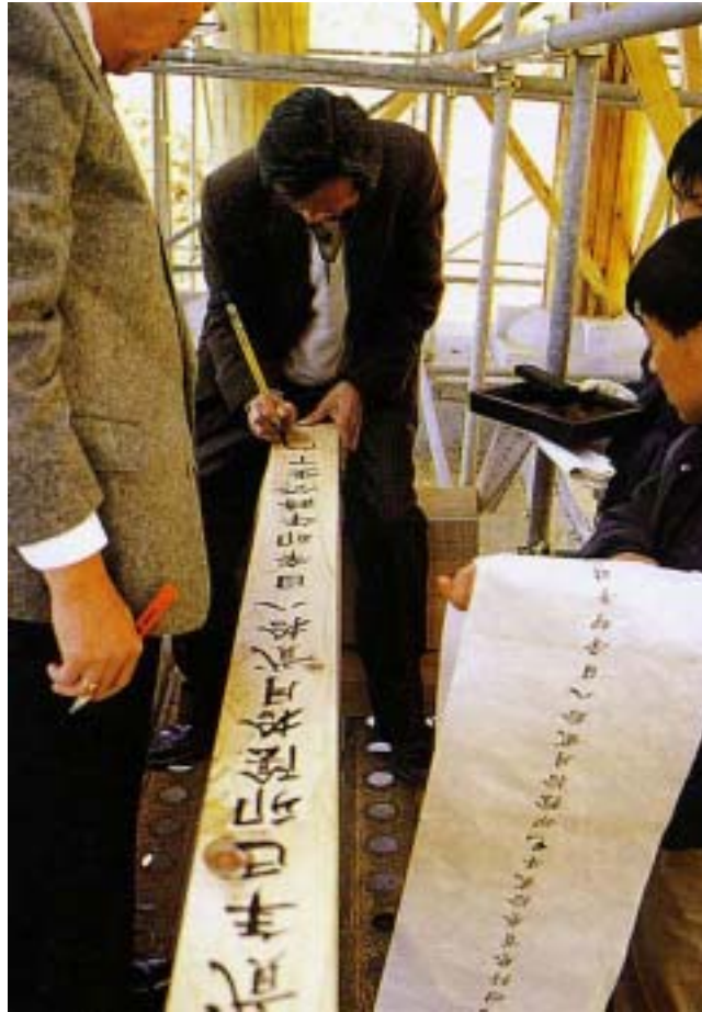
사진67. 상량시에 장혀에 상량일시를 적는다.
