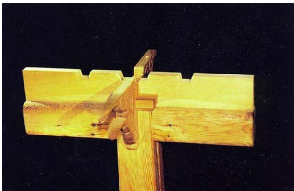
사진55. 이익공 설치
