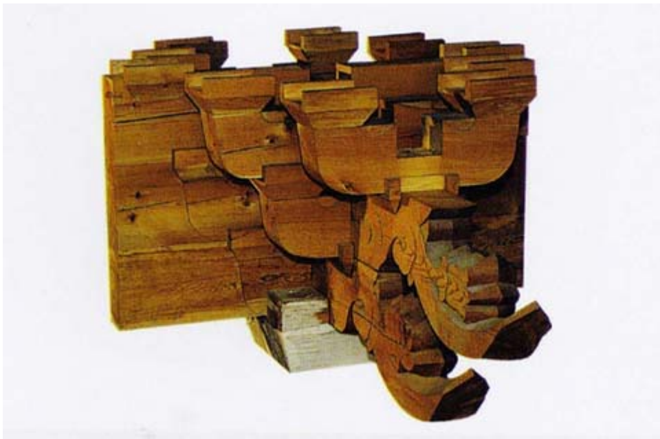
사진96. 외2출목 소침 설치(2)
