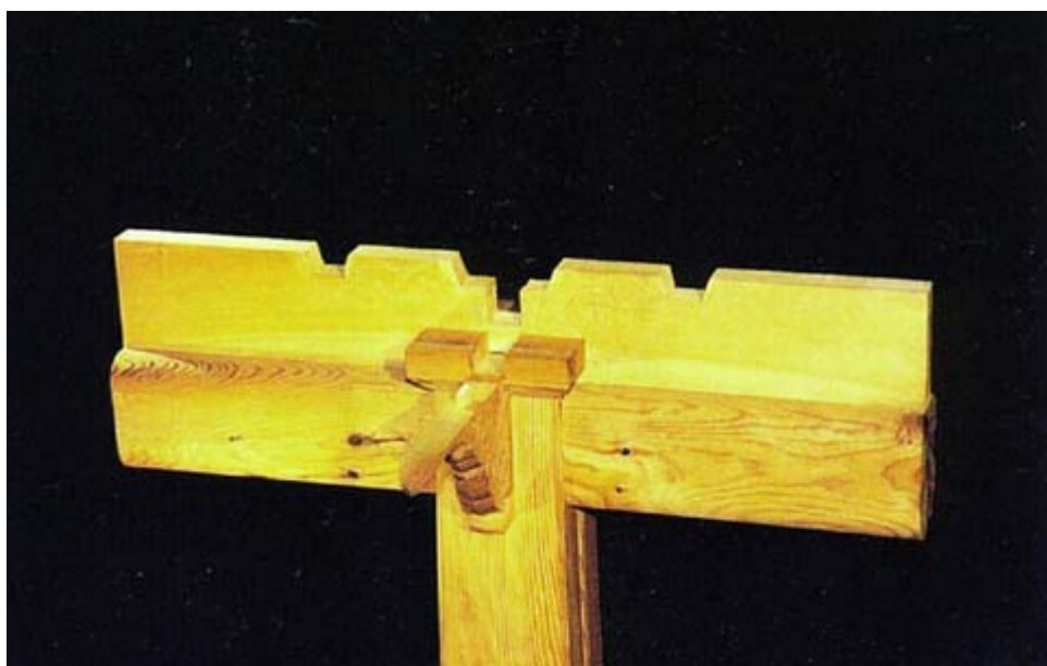
사진54. 장화반 설치
