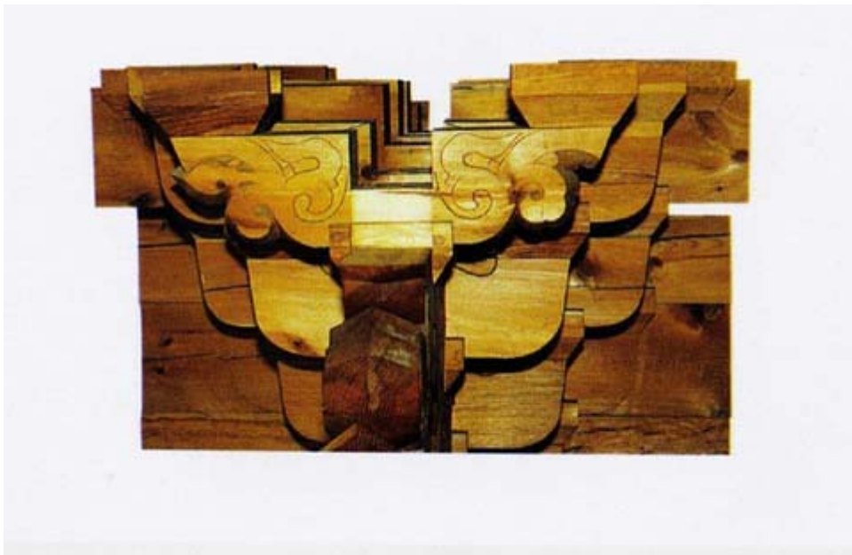
사진98. 외3출 소첨, 주심장혀, 내3출 소첨 설치
