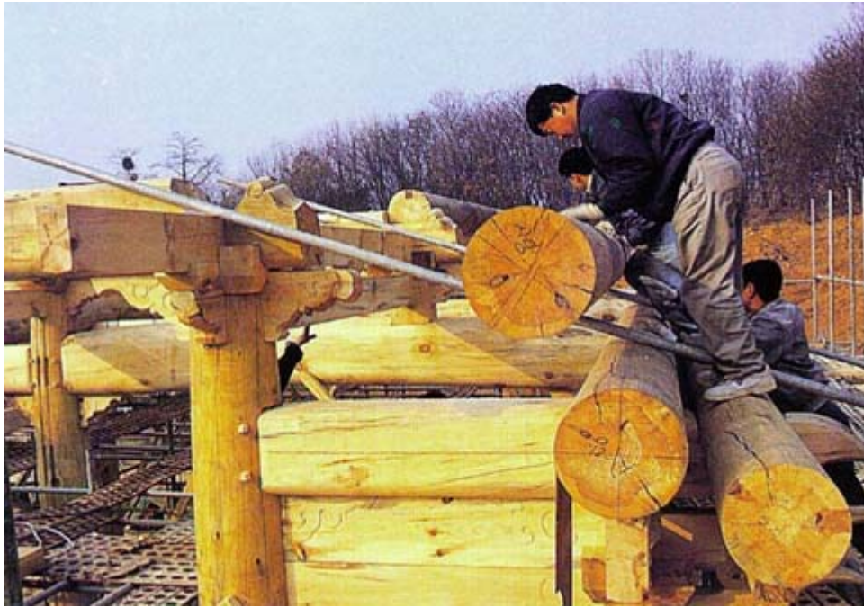
사진140. 출목도리 주심도리 설치 후 종도리 올리는 과정
