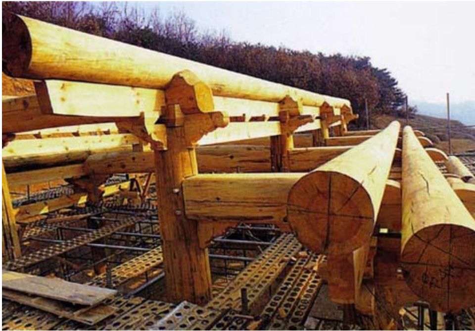
사진142. 종도리까지 설치
