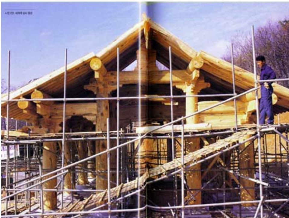
사진153. 서까래 설치 완성
