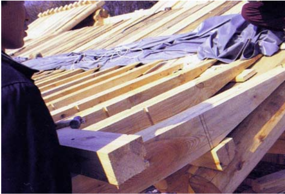
사진152. 부연 설치
