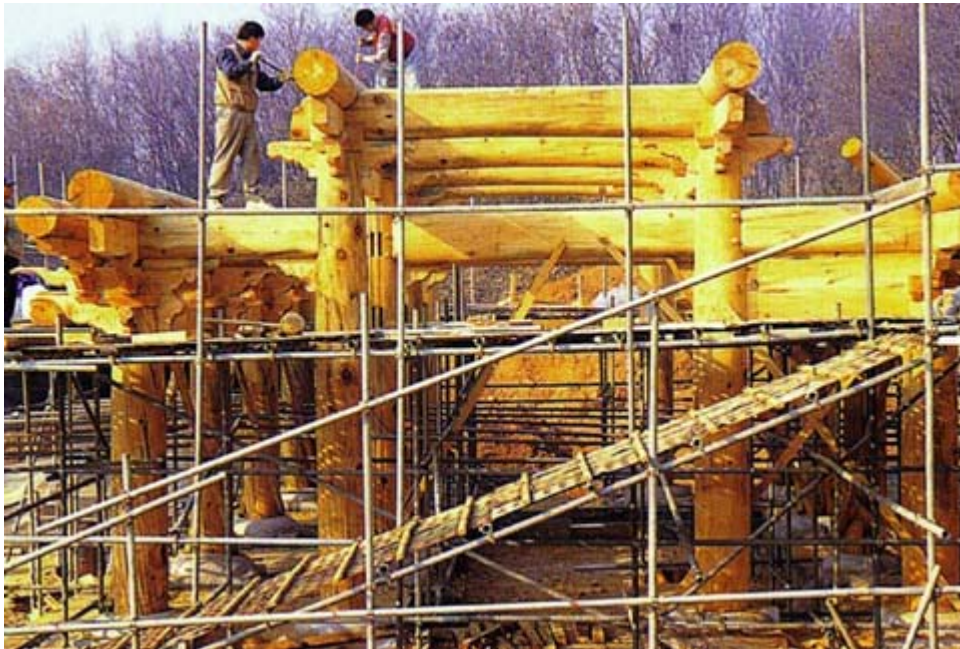
사진143. 종도리까지 설치
