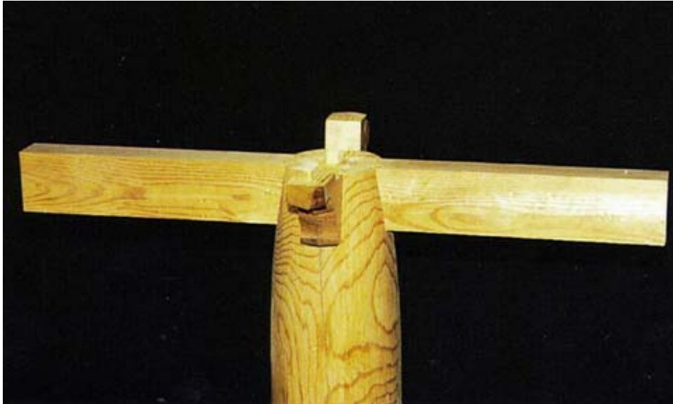
사진78. 익공과 창방 설치
