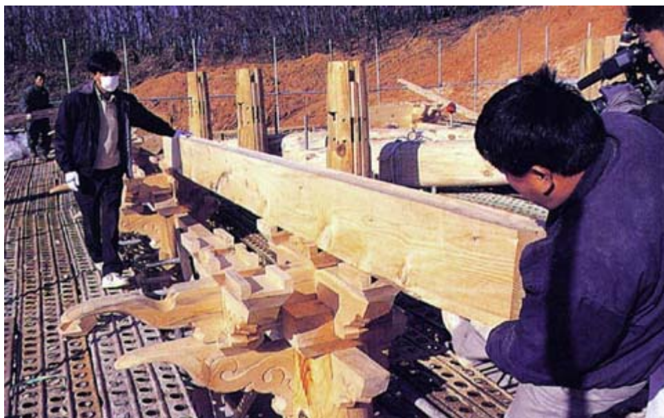
사진125. 장혀 설치 모습
